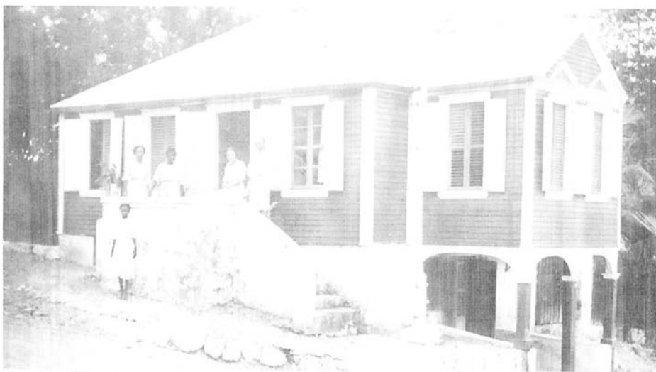
Herdis Riis-Jacobsen sammen med sin mand ved indgangen til deres hus i Frederiksted "The Pancake House", ca 1915 - privat foto.
